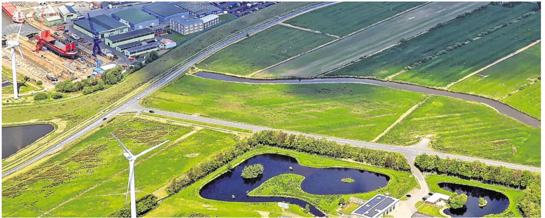
Dem Verkehr entzogen: Still liegt der nördliche Teil der defekten Straße da. Das Auto an der hafenseitigen Einmündung parkt nur an der Absperrung.
